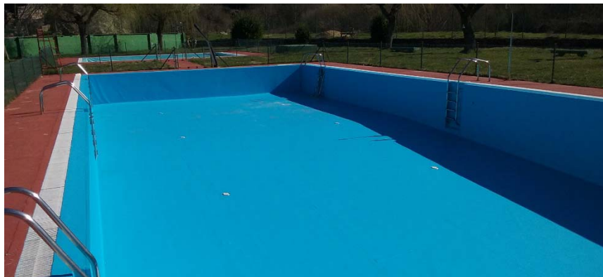
Vista de lámina piscinas de Matarrosa del Sil, liner de piscina grande renovado recientemente
