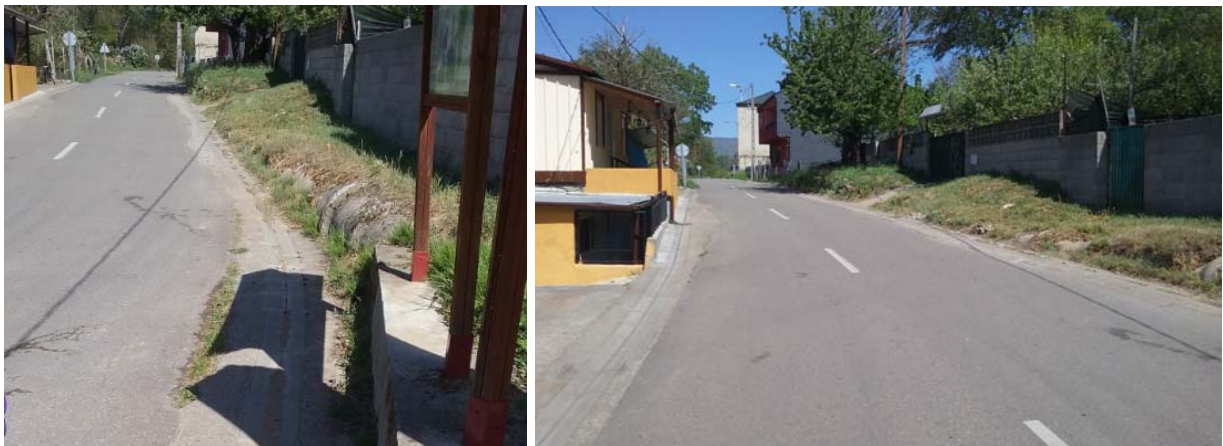
Vistas de caz en tramo norte, margen este
