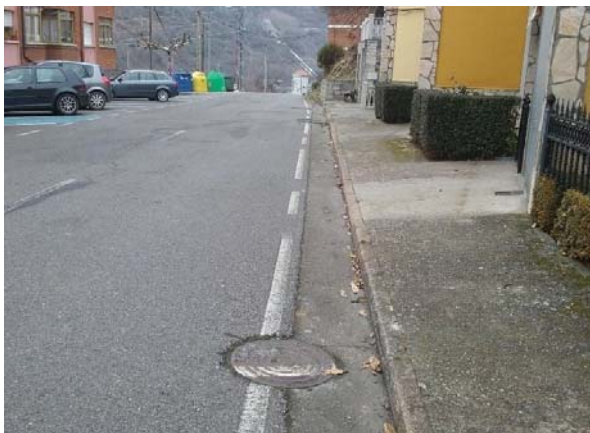
Tramo con acera y pozo de saneamiento Barrio Mirador
