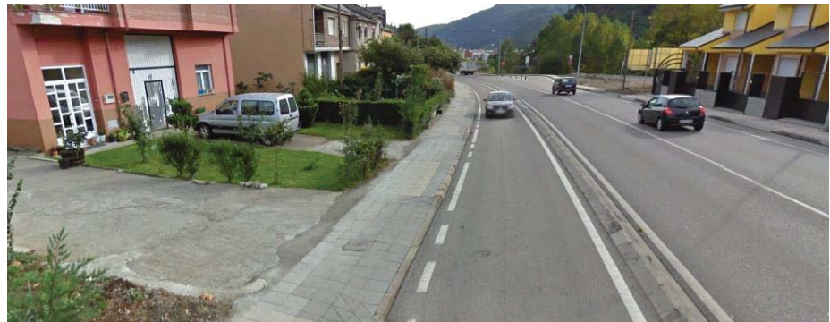
Acera en tramo final con tubería de fibrocemento
