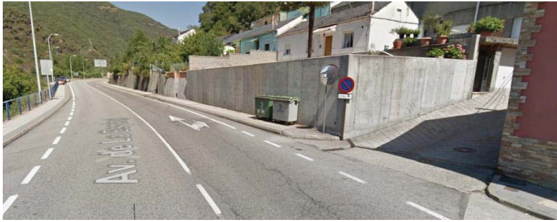
Cruce de calle General Moscadó con la Avda. de La Espina
