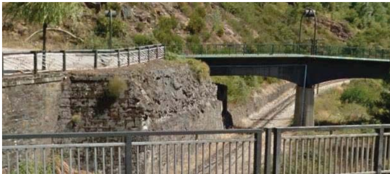
Llegada a la avenida por la pasarela peatonal, tubería colgada de la misma
