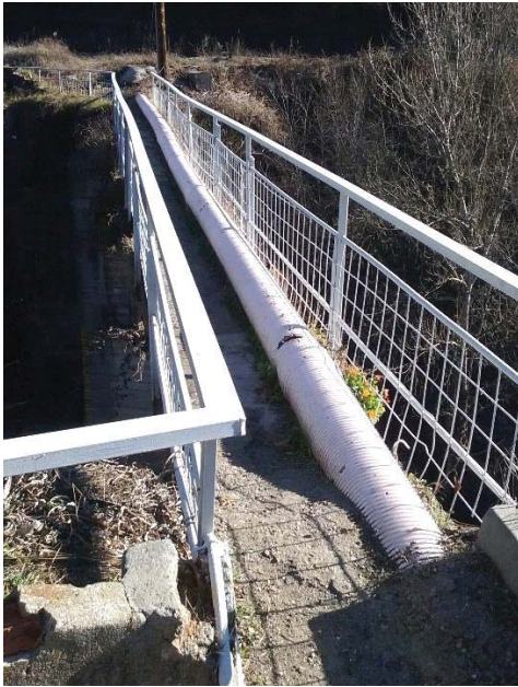
Tramo inicial sobre pasarela metálica
