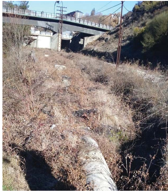
Tramo en paralelo al ferrocarril (pasarela peatonal al fondo)
