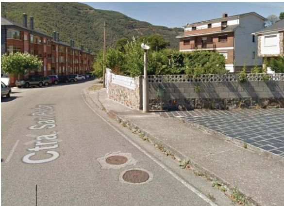
Inicio aguas arriba de la red de saneamiento Barrio Mirador
