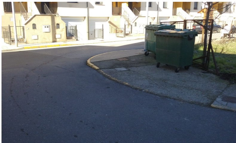
Vistas de acera de calle La Fornilla en cruce con calle La Chana
