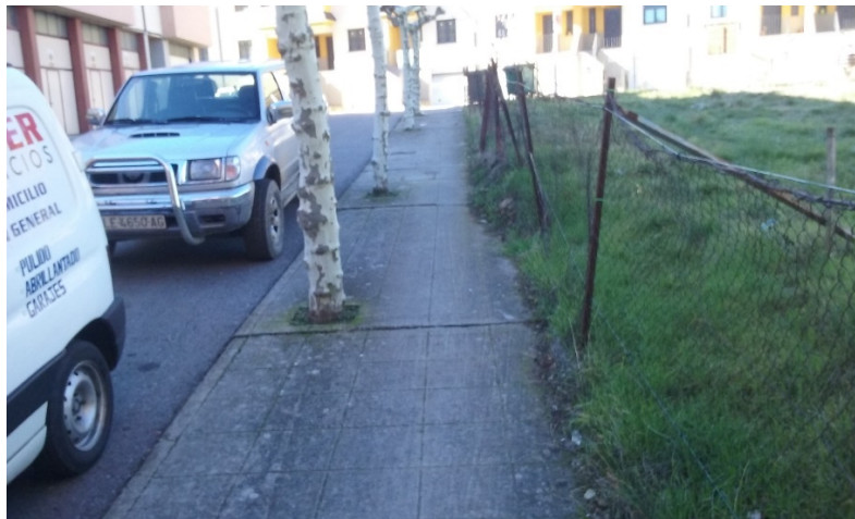
Vistas de acera de calle La Fornilla
